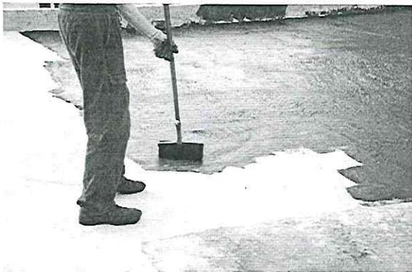
Fig.01 - Impermeabilização com Emulsão Asfáltica
