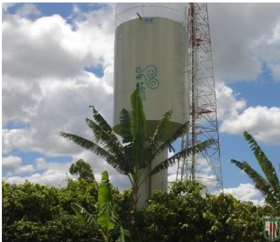
Figura 38 – Reservatório no bairro Scarpini
