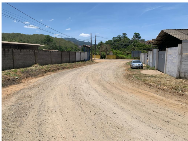
Foto 01: Regularização e compactação de base
