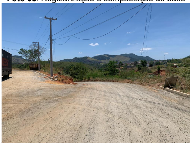
Foto 07: Regularização e compactação de base
