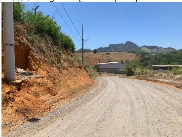
Foto 03: Regularização e compactação de base
