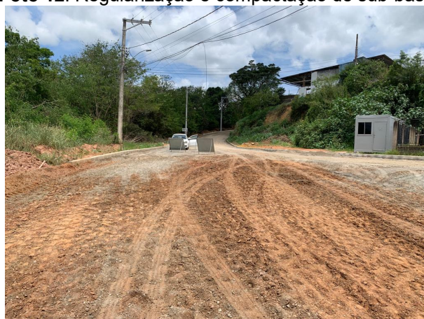
Foto 14: Regularização e compactação de sub-base
