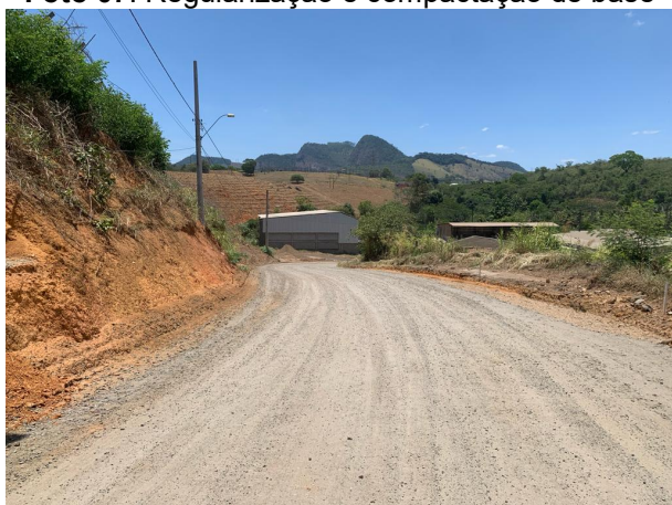
Foto 09: Regularização e compactação de base
