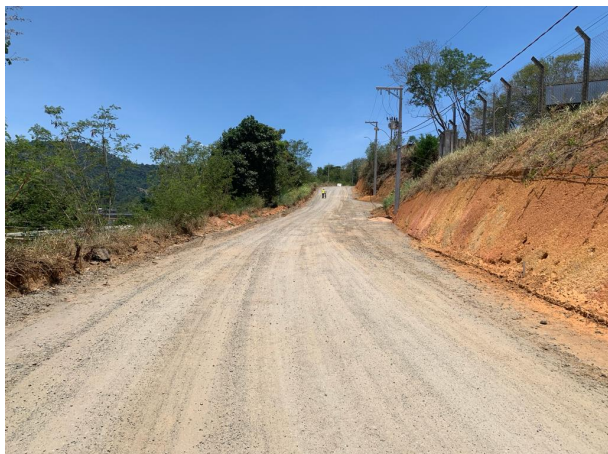
Foto 05: Regularização e compactação de base
