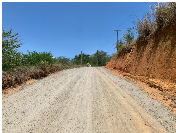
Foto 06: Regularização e compactação de base
