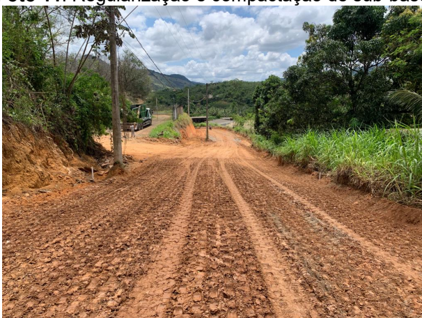
Foto 13: Regularização e compactação de sub-base
