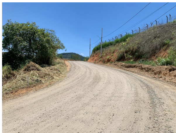
Foto 02: Regularização e compactação de base
