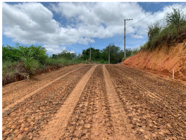
Foto 12: Regularização e compactação de sub-base
