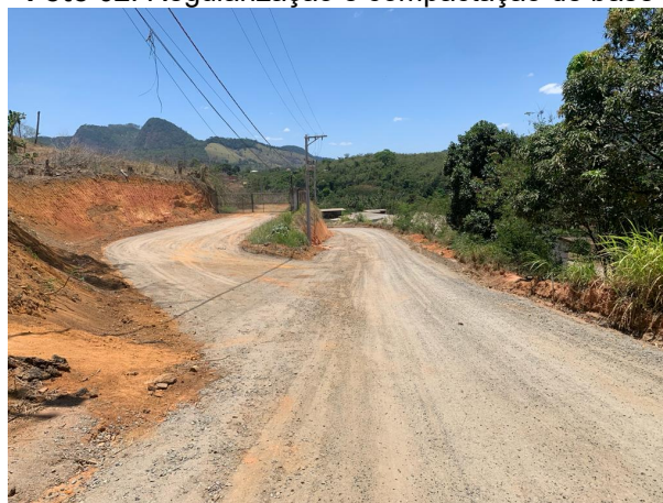
Foto 04: Regularização e compactação de base
