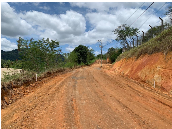
Foto 11: Regularização e compactação de sub-base
