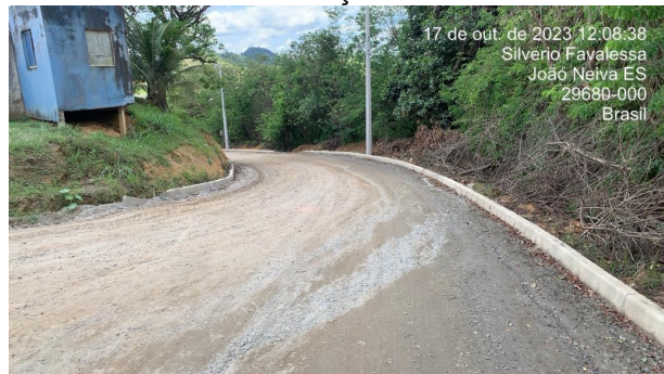
Foto 10: Execução de meio fio
