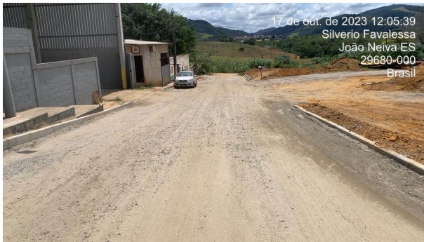
Foto 07: Execução de meio fio
