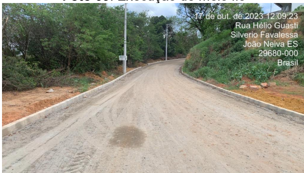
Foto 11: Execução de meio fio
