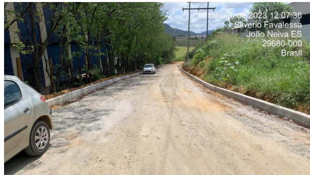
Foto 08: Execução de meio fio
