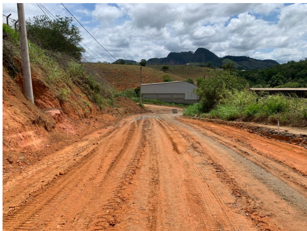
Foto 22: Execução de meio fio
