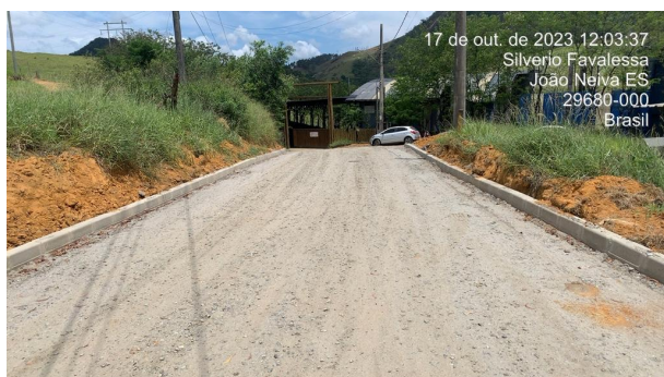
Foto 01: Execução de meio fio
