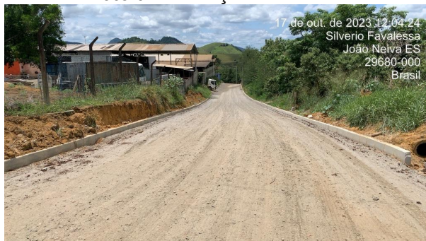
Foto 04: Execução de meio fio
