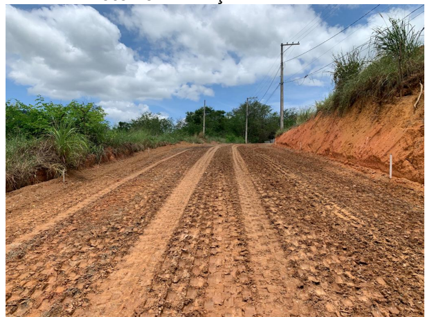
Foto 20: Execução de meio fio
