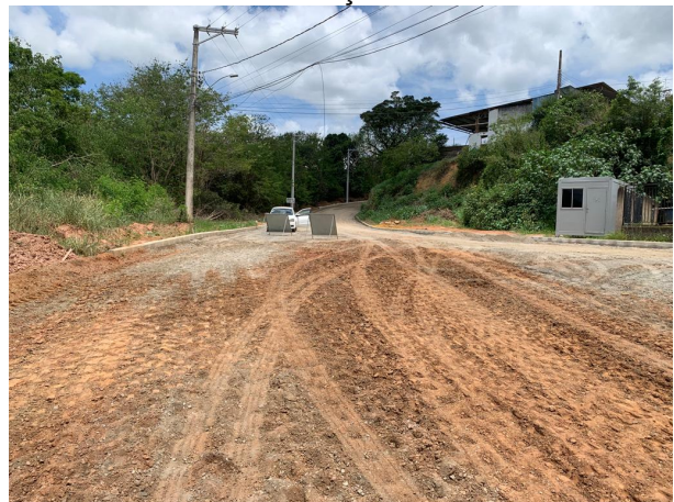
Foto 18: Execução de meio fio
