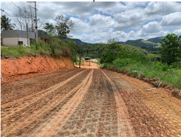
Foto 17: Execução de meio fio
