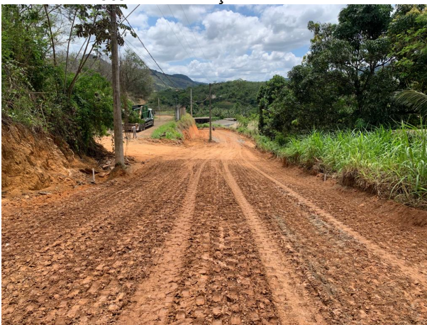
Foto 19: Execução de meio fio
