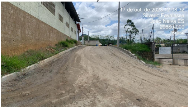
Foto 09: Execução de meio fio
