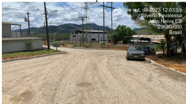
Foto 03: Execução de meio fio
