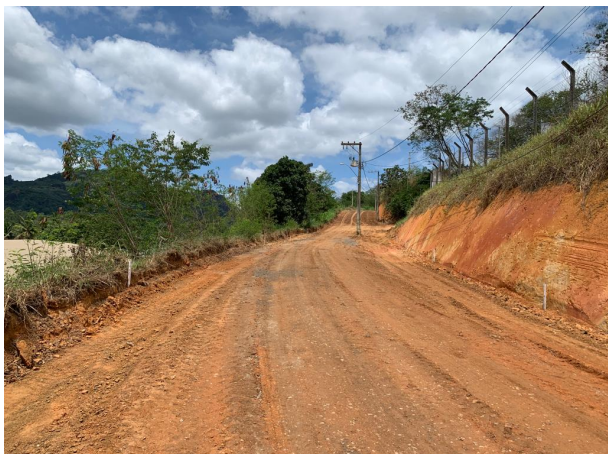
Foto 21: Execução de meio fio
