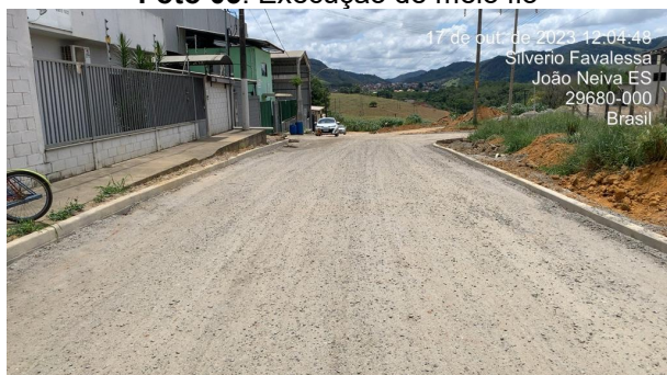
Foto 05: Execução de meio fio
