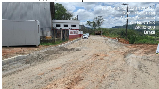
Foto 12: Execução de meio fio
