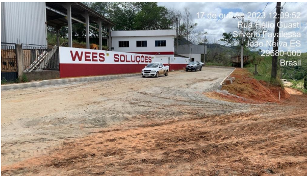
Foto 15: Execução de meio fio
