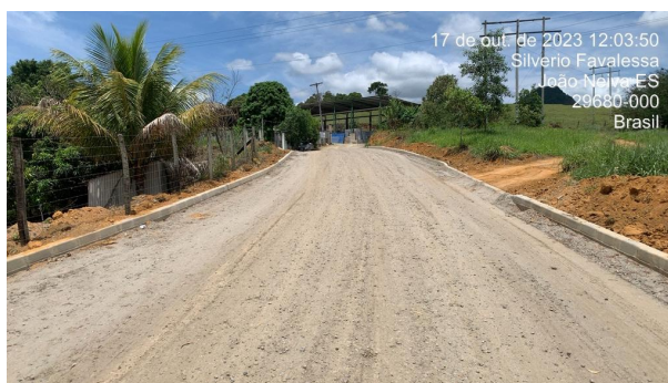
Foto 02: Execução de meio fio
