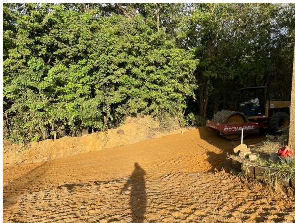
Foto 06: Regularização e Compactação
