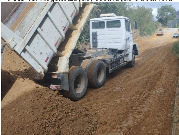
Foto 15: Regularização, escavação e bota-fora
