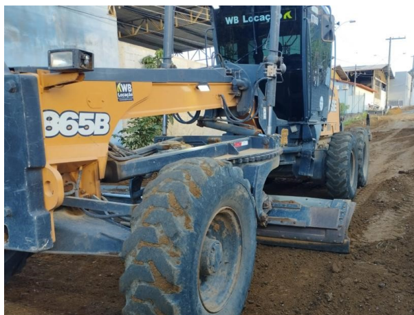
Foto 02: Regularização e Compactação
