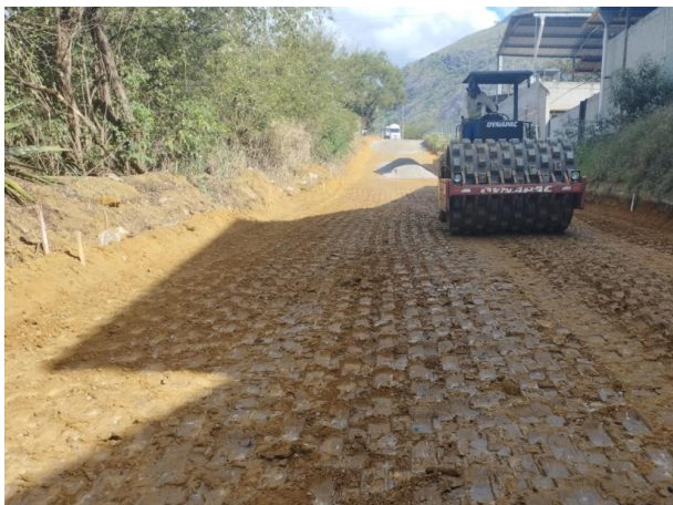
Foto 17: Regularização, escavação e bota-fora
