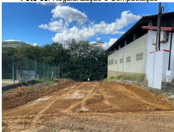
Foto 10: Regularização e Compactação
