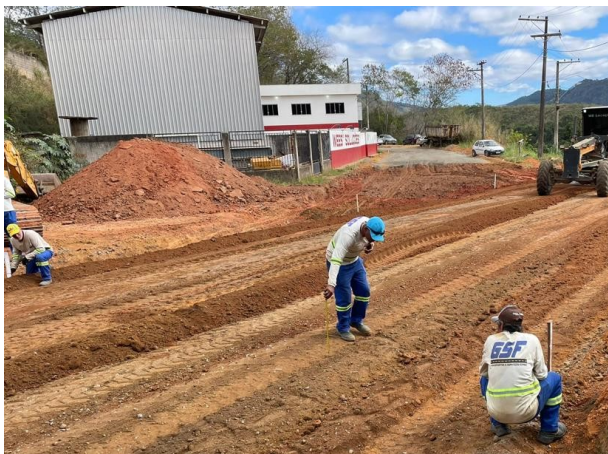
Foto 05: Regularização e Compactação
