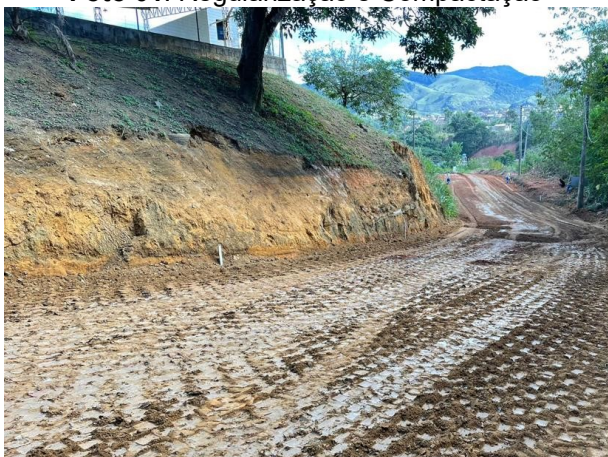
Foto 03: Regularização e Compactação
