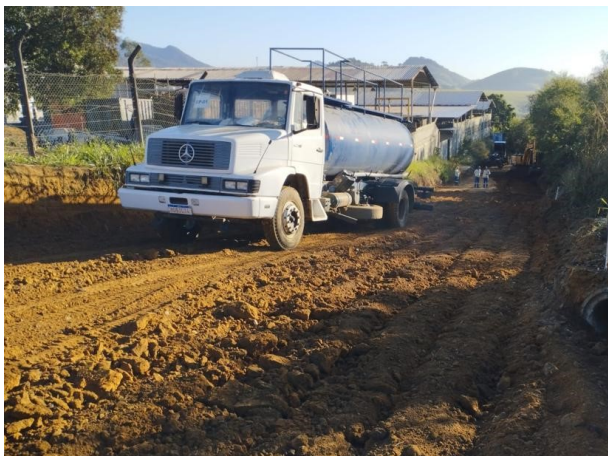
Foto 11: Regularização, escavação e bota-fora
