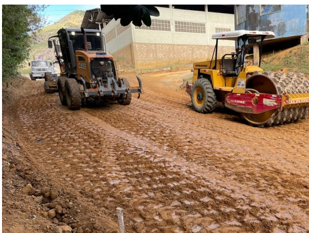
Foto 01: Regularização e Compactação
