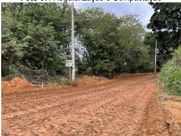
Foto 09: Regularização e Compactação
