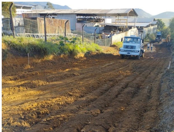
Foto 12: Regularização, escavação e bota-fora
