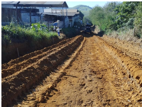
Foto 18: Regularização, escavação e bota-fora
