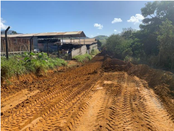
Foto 11: Regularização, escavação e bota-fora
