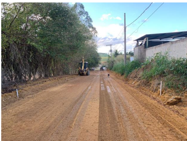
Foto 01: Regularização e Compactação
