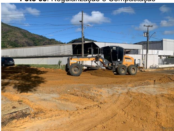
Foto 07: Regularização e Compactação
