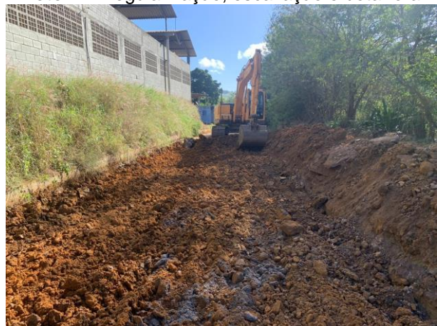
Foto 14: Regularização, escavação e bota-fora
