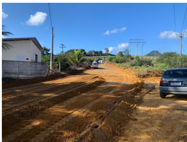
Foto 06: Regularização e Compactação
