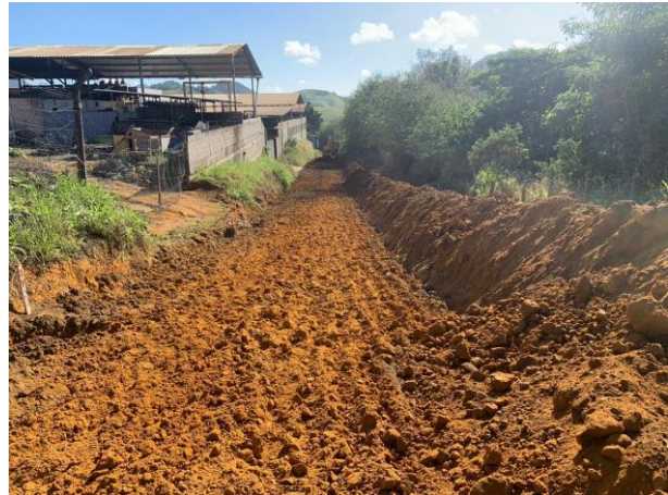
Foto 12: Regularização, escavação e bota-fora
