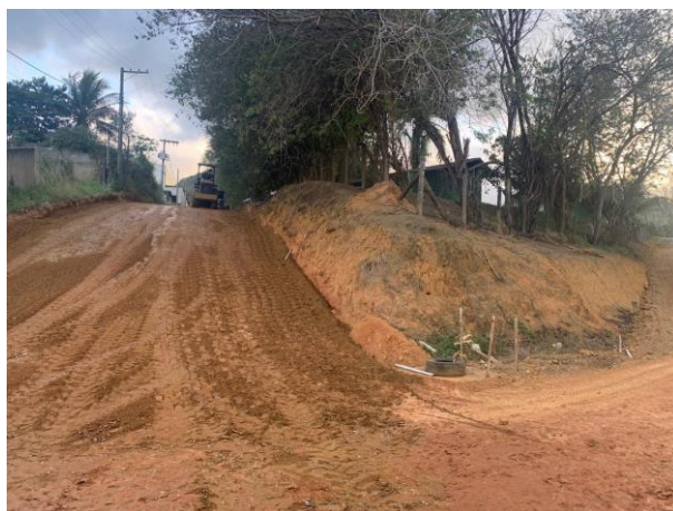
Foto 02: Regularização e Compactação
