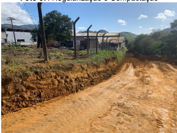
Foto 09: Regularização e Compactação
