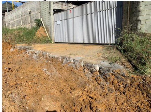
Foto 16: Regularização, escavação e bota-fora
