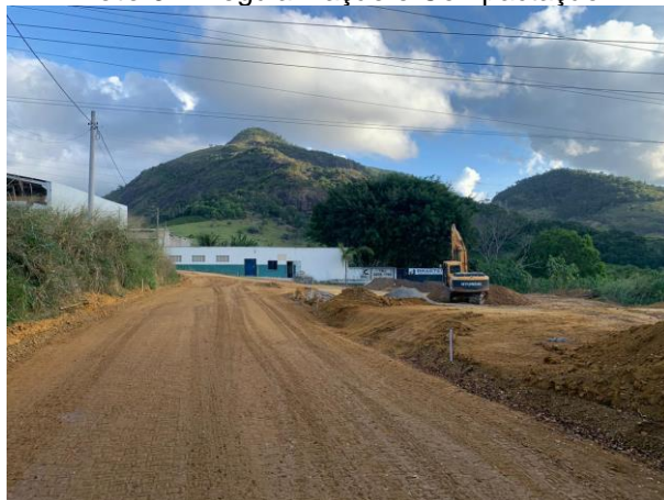
Foto 04: Regularização e Compactação
