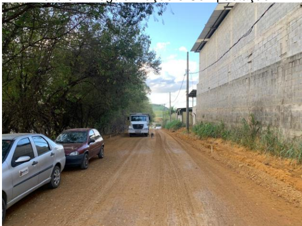
Foto 03: Regularização e Compactação
