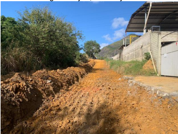
Foto 15: Regularização, escavação e bota-fora
