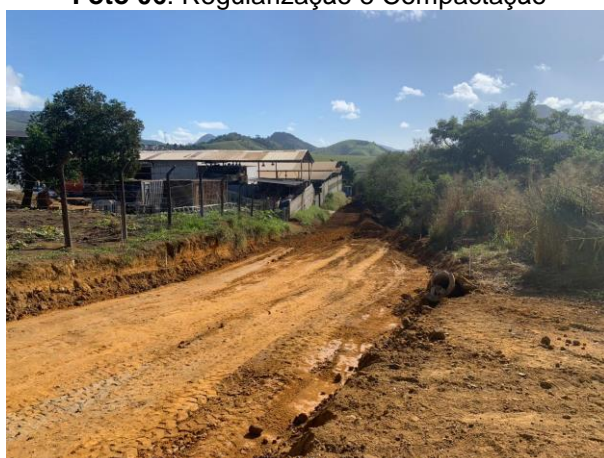
Foto 08: Regularização e Compactação
