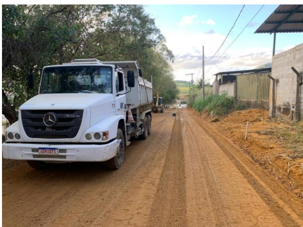
Foto 05: Regularização e Compactação
