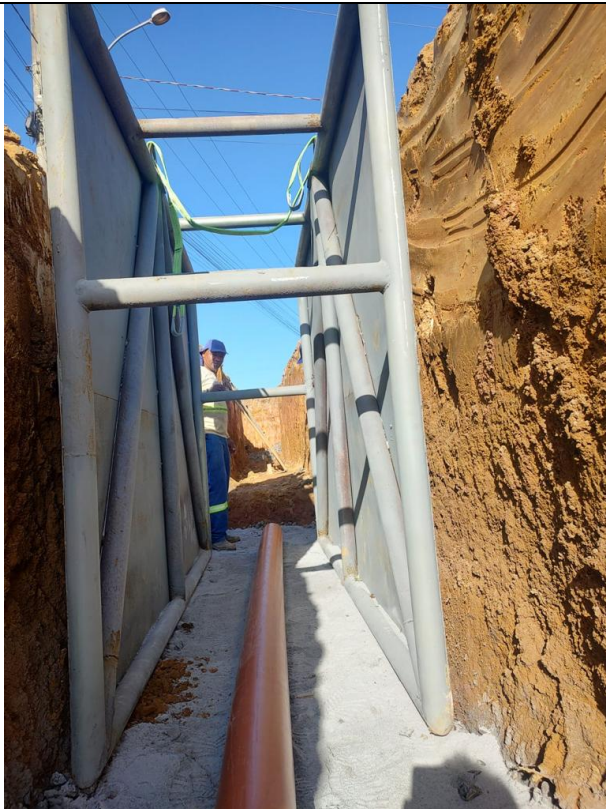
Foto 03: Escoramento Metálico, escavação, regularização e assentamento de tubo
