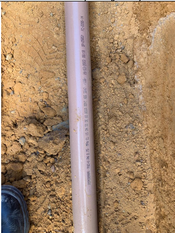
Foto 09: Assentamento de tubo
