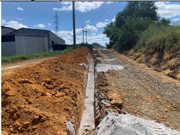
Foto 05: Escavação, regularização e aterro
