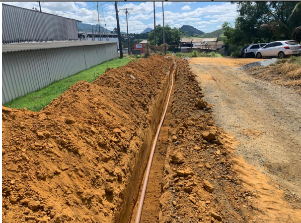
Foto 05: Escavação, regularização e aterro
