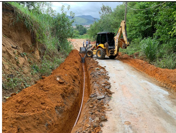
Foto 12: escavação, regularização e assentamento de tubo
