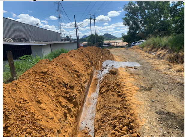
Foto 06: Escavação, regularização e aterro
