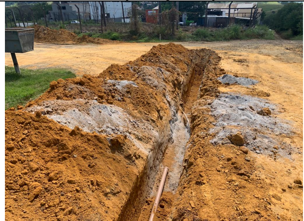
Foto 06: Escavação, regularização e aterro
