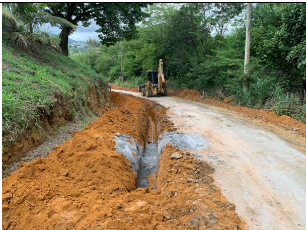
Foto 11: escavação, regularização e assentamento de tubo
