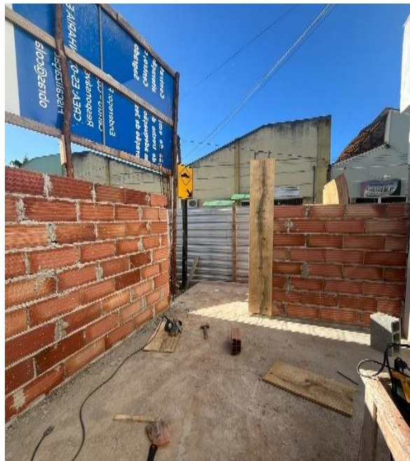
Alvenaria em bloco
