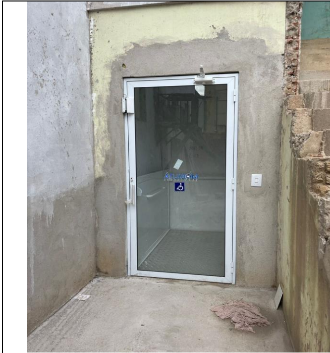
Fornecimento e instalação de plataforma elevatória
