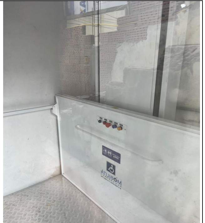
Fornecimento e instalação de plataforma elevatória
