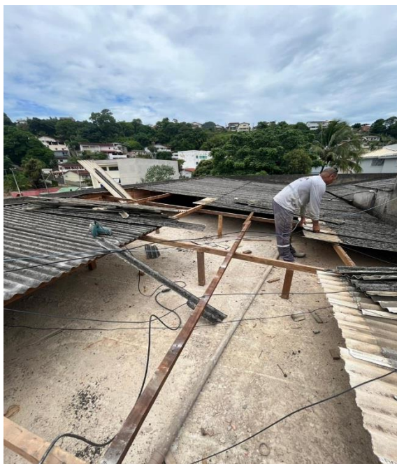
Demolição de telhado e troca de madeiras e telhas
