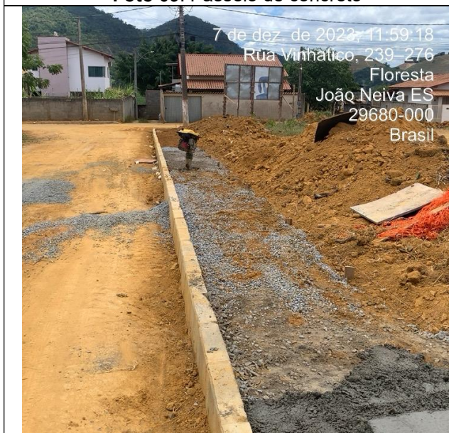
Foto 11: Base de brita e regularização de base para passeio
