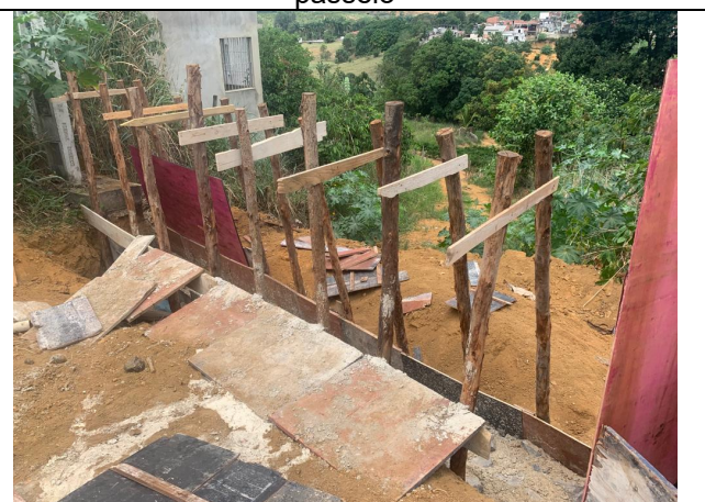
Foto 14: Muro de contenção em concreto ciclópico
