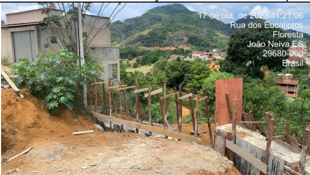
Foto 17: Muro de contenção em concreto ciclópico
