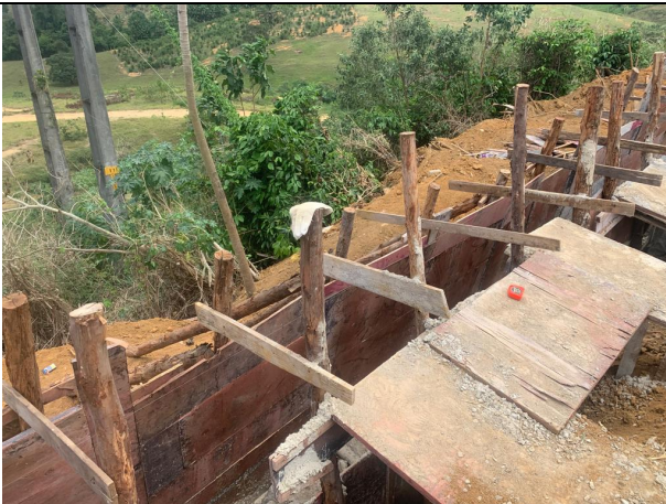
Foto 15: Muro de contenção em concreto ciclópico
