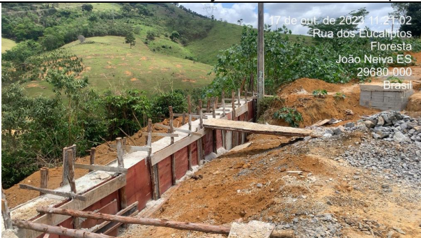
Foto 17: Muro de contenção em concreto ciclópico
