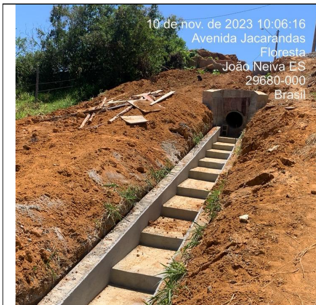
Foto 01: Descida d'água e saída de bueiro
