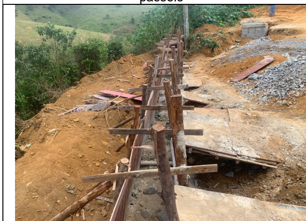
Foto 13: Muro de contenção em concreto ciclópico
