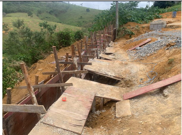
Foto 16: Muro de contenção em concreto ciclópico
