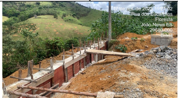
Foto 18: Muro de contenção em concreto ciclópico
