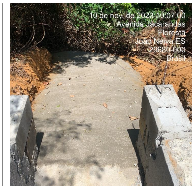
Foto 17: Final de descida d'água
