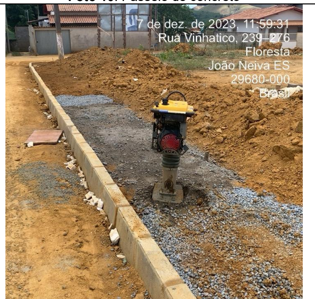
Foto 12: Base de brita e regularização de base para passeio
