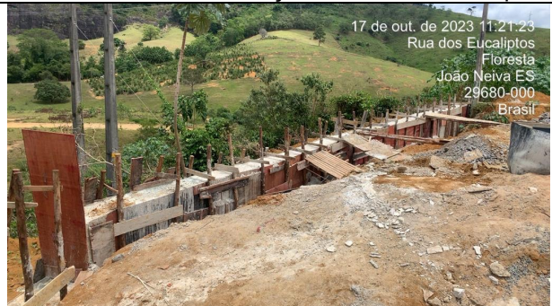
Foto 18: Muro de contenção em concreto ciclópico
