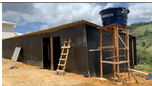
Foto 02: Barracão e reservatório
