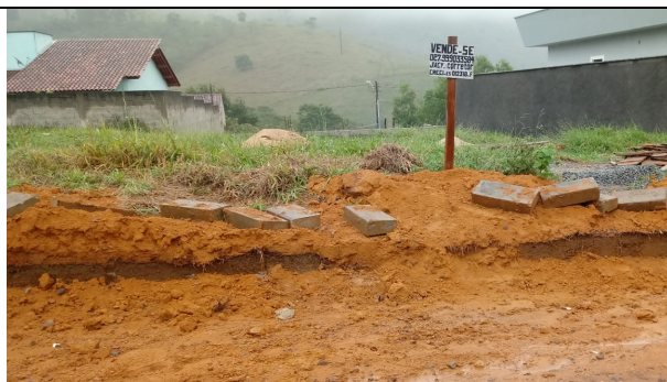
Foto 14: Retirada de meio fio
