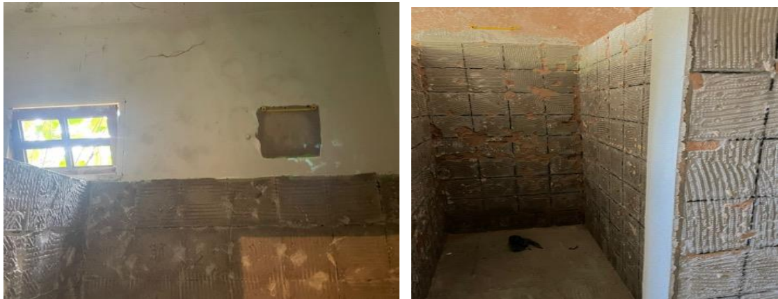
Demolição parede e remoção de cerâmica
