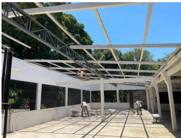
Demolição de teto e piso
