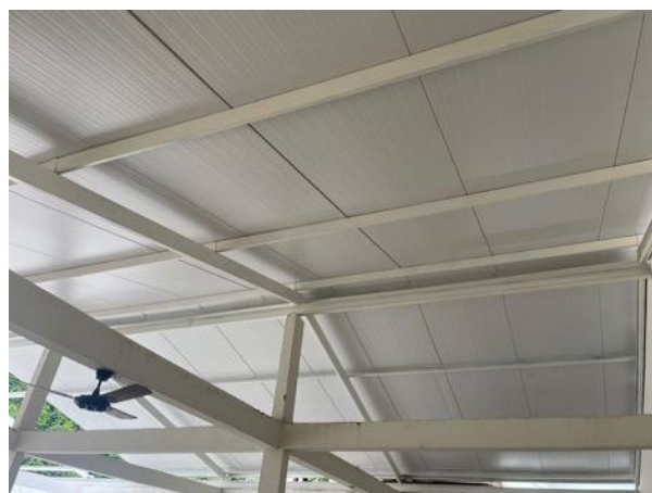
Ferragem para cobertura metalica e telha termoautistica
