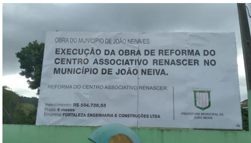
Foto 01: Placa de obra
