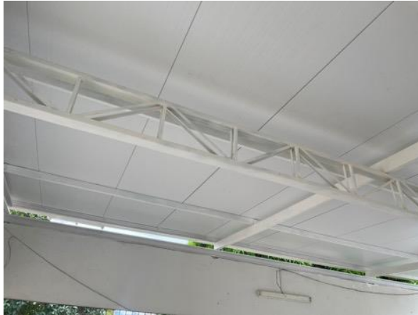
Estrutura metálica com telhas termoacústicas
