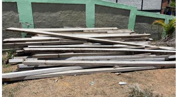
Resto de demolição
