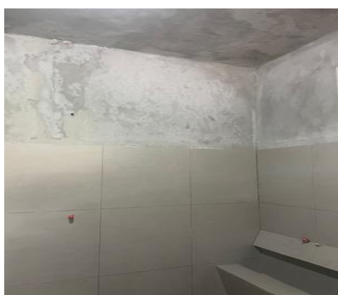
Assentamento ceramico e reboco de tetos e paredes
