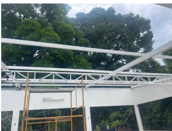
Ferragem para cobertura metalica e telha termoautistica
