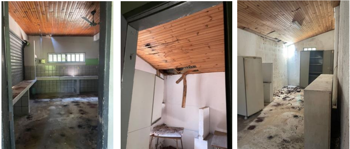
Demolição de teto e piso
