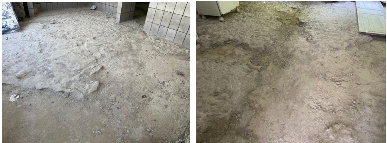
Demolição piso e cerâmica
