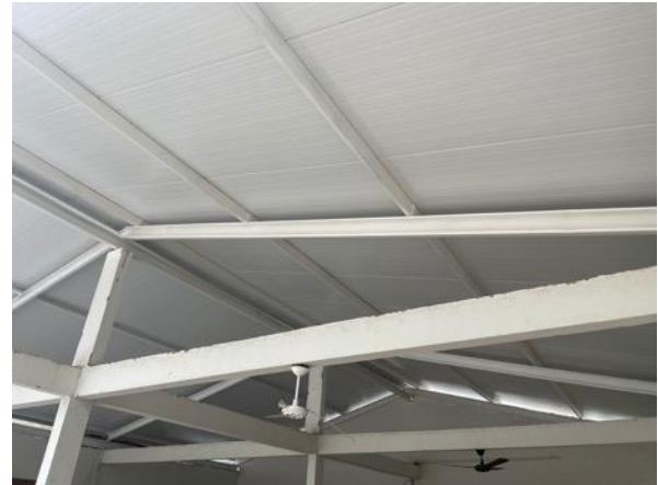
Estrutura metálica com telhas termoacústicas
