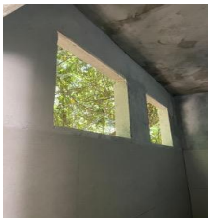
Assentamento ceramico e reboco de tetos e paredes
