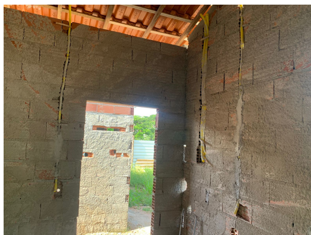
Foto 06: Chapisco e eletroduto
