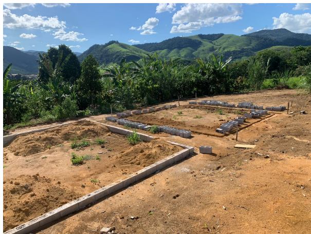
Foto 12: Escavações e cintamento
