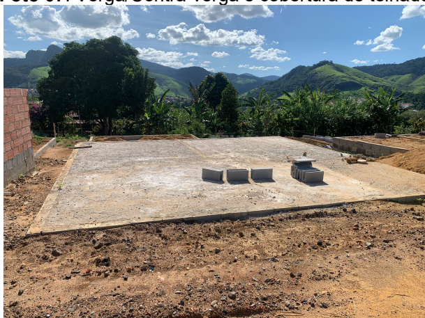
Foto 09: Lastro de concreto
