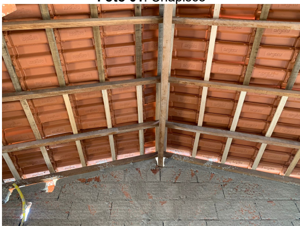
Foto 03: Estrutura de madeira para telhado e telhado
