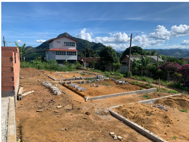
Foto 11: Escavações e cintamento
