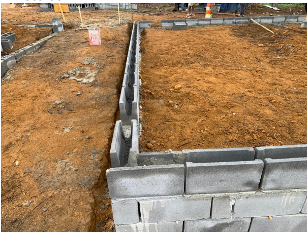
Foto 07: Blocos de concreto cheio e canaletas
