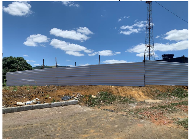
Foto 22: instalação de tapume
