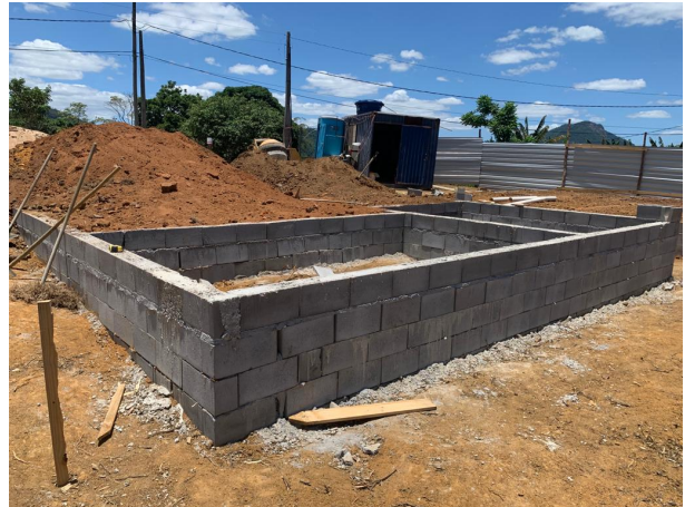
Foto 18: blocos de concreto cheio e canaleta
