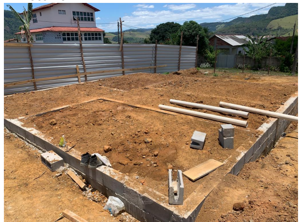
Foto 20: aterro e compactação
