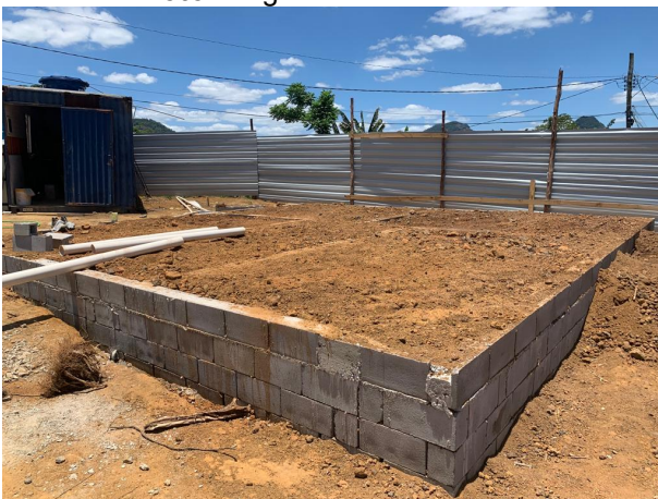
Foto 19: aterro e compactação
