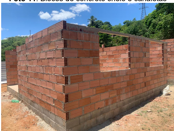
Foto 13: alvenaria com lajota cerâmica
