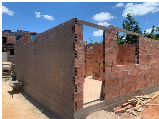
Foto 12: alvenaria com lajota cerâmica e chapisco
