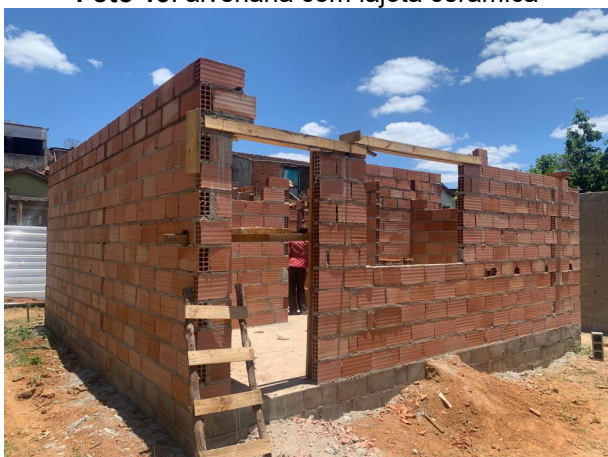
Foto 15: alvenaria com lajota cerâmica
