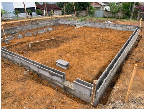
Foto 01: Blocos de concreto cheio e canaletas
