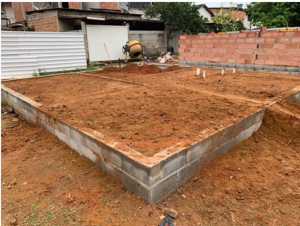
Foto 09: aterro e pontos de esgoto
