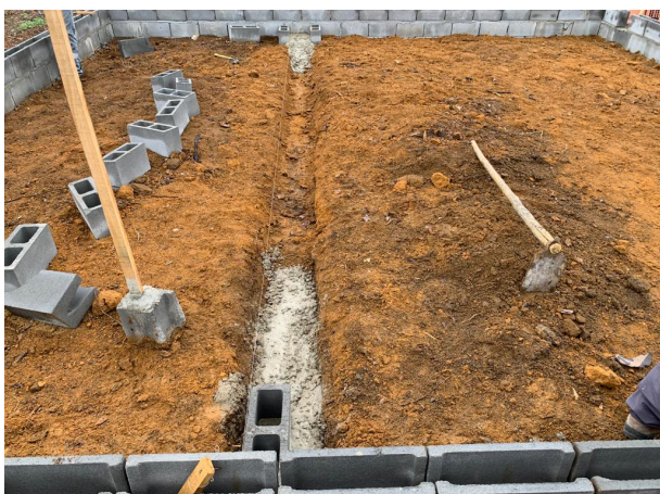
Foto 11: Blocos de concreto cheio e canaletas
