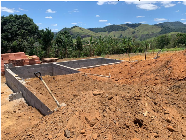
Foto 21: aterro e compactação
