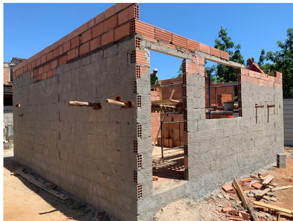
Foto 24: alvenaria com lajota cerâmica e chapisco
