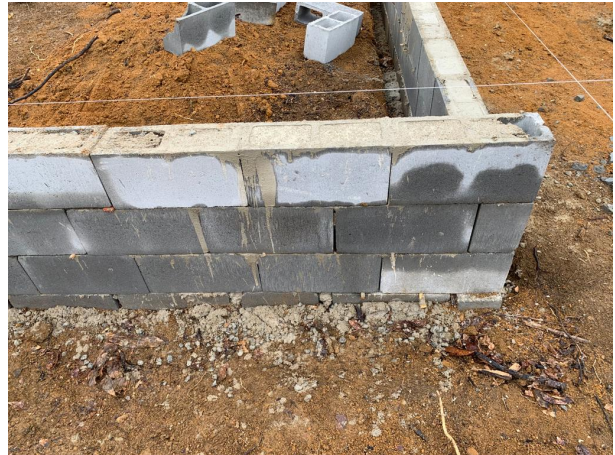
Foto 06: Blocos de concreto cheio e canaletas
