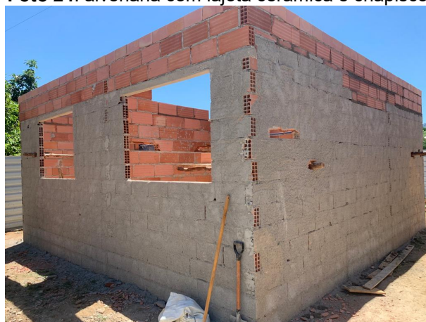
Foto 26: alvenaria com lajota cerâmica e chapisco
