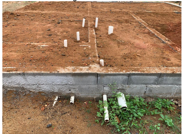
Foto 10: aterro e pontos de esgoto
