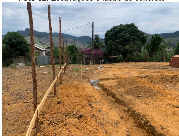
Foto 04: Escavações e lastro de concreto
