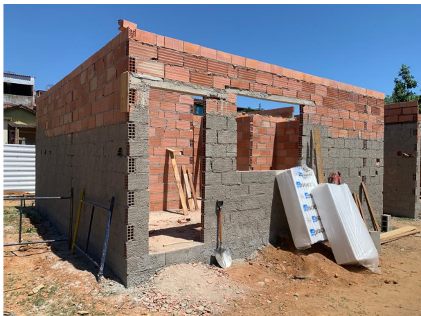
Foto 23: alvenaria com lajota cerâmica e chapisco
