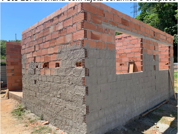
Foto 25: alvenaria com lajota cerâmica e chapisco
