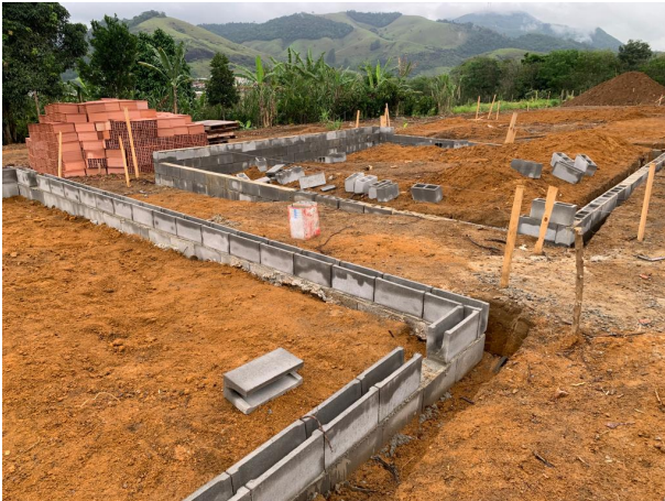
Foto 05: Blocos de concreto cheio e canaletas
