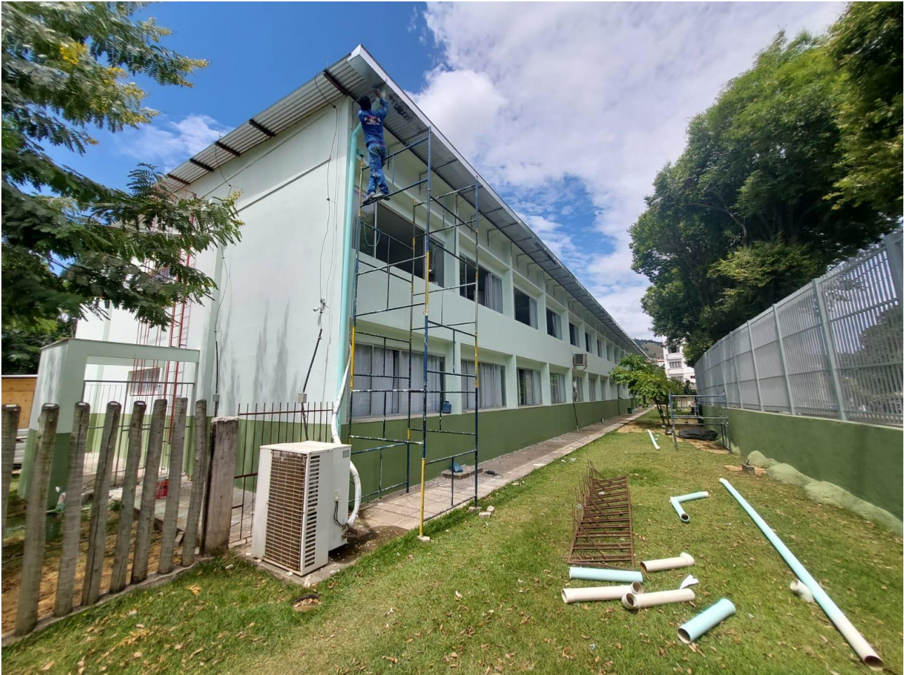
Foto 03: recolocando tubo de queda
