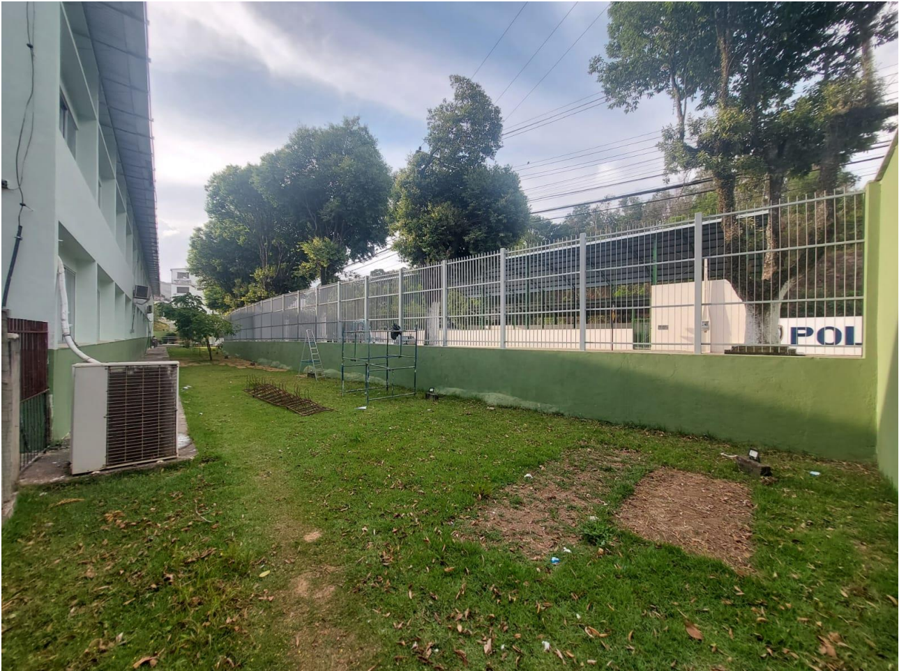
Foto 01: instalação de grama
