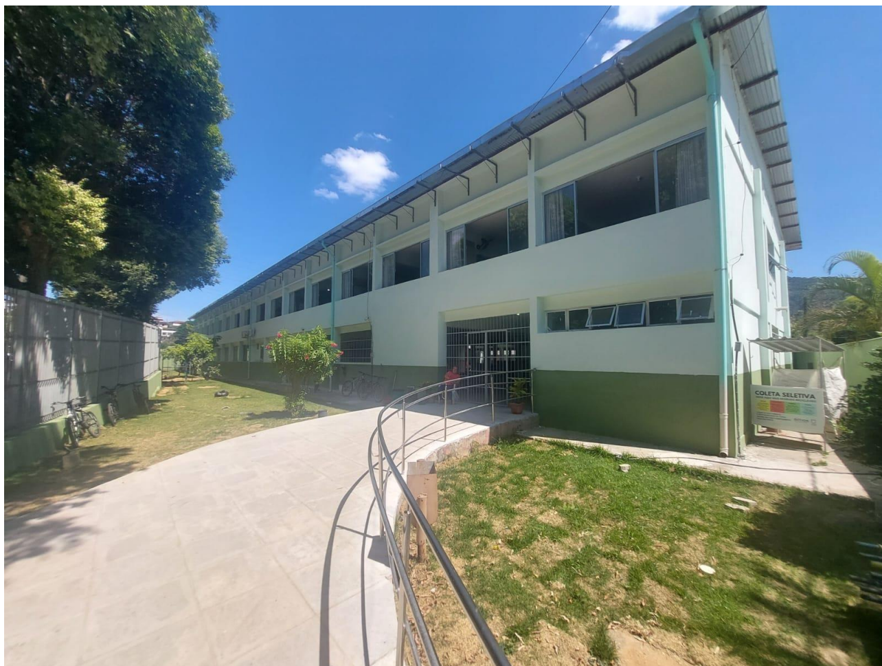
Foto 08: revestimento da rampa
