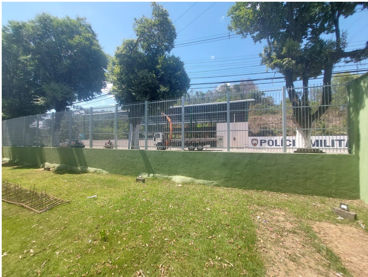
Foto 07: retoque de pintura do muro
