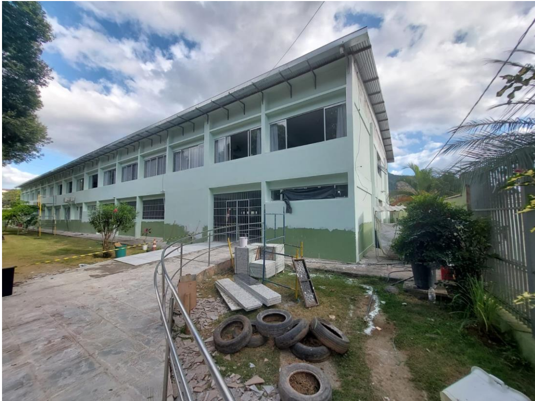
Foto 03: Regularização de fachada
