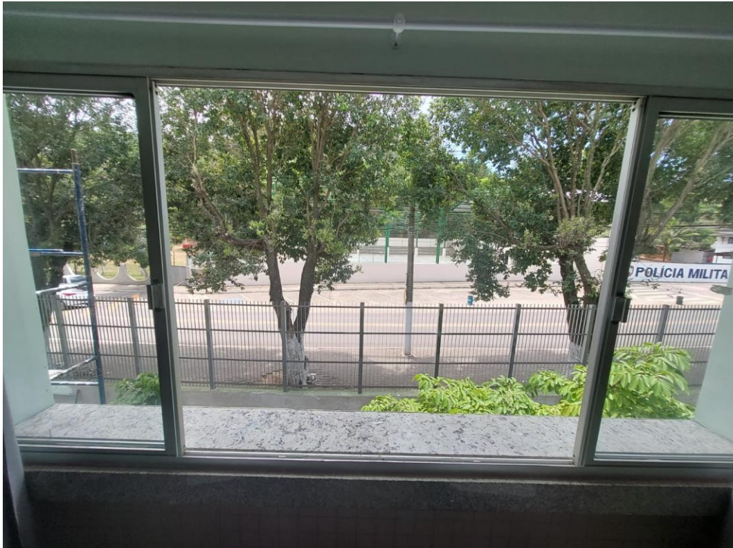
Foto 05: Peitoril de granito nas janelas
