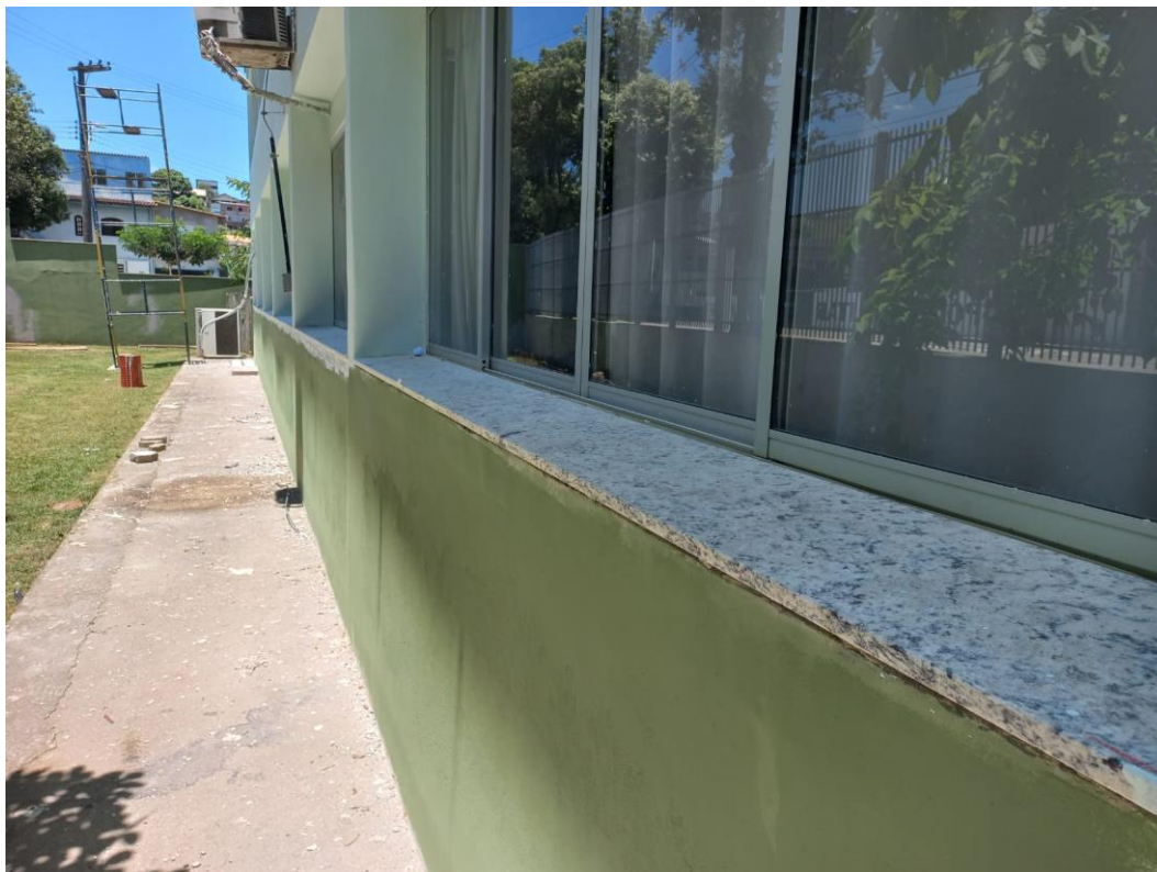
Foto 07: Peitoril de granito nas janelas
