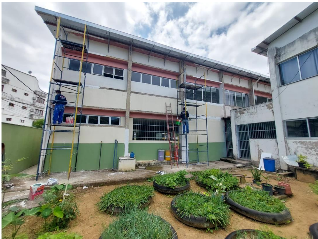
Foto 04: Regularização de fachada dos fundos
