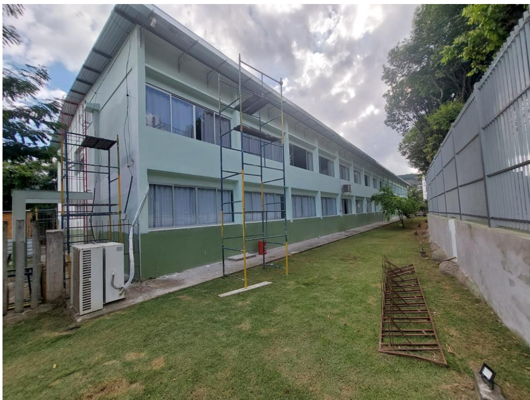
Foto 02: Regularização de fachada
