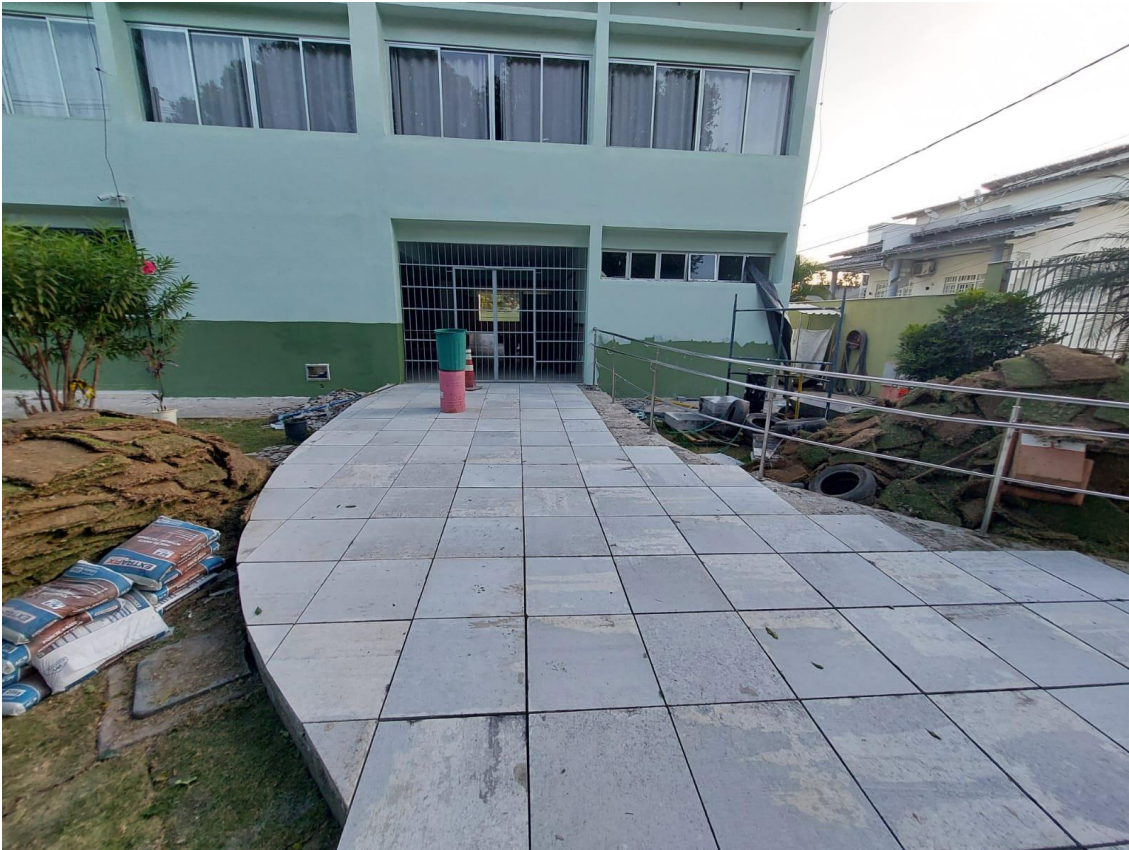
Foto 01: Instalação de granito na rampa
