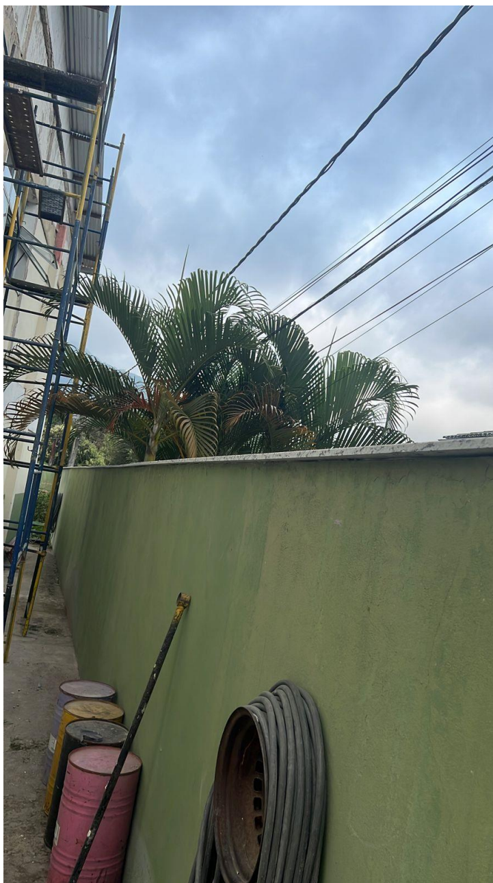
Foto 07: Chapim sobre muros
