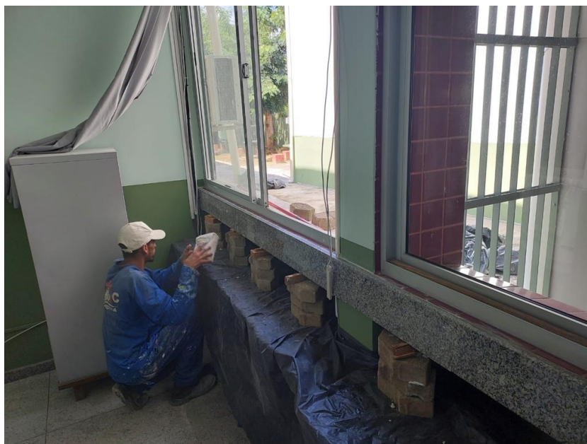
Foto 16: revestimento de granito
