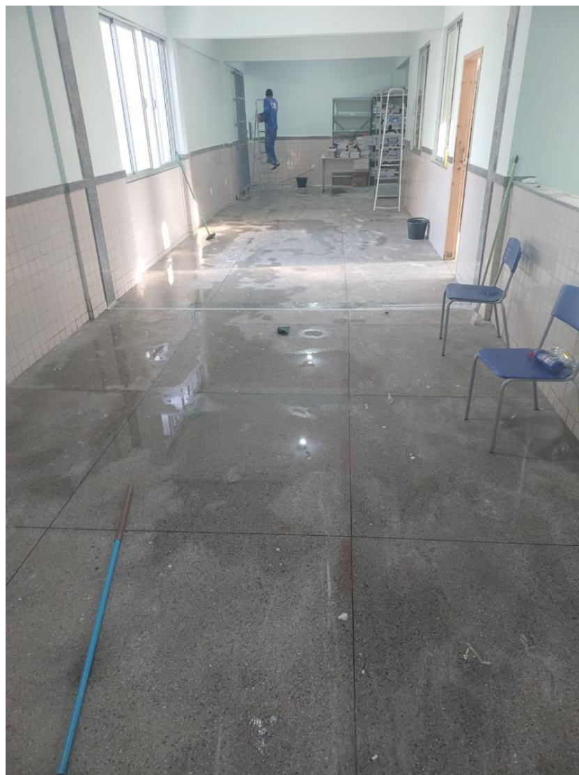
Foto 06: Limpeza de obras
