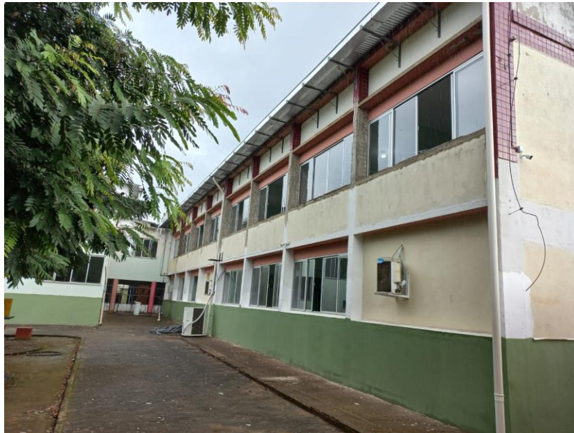
Foto 09: recuperação e pintura da fachada
