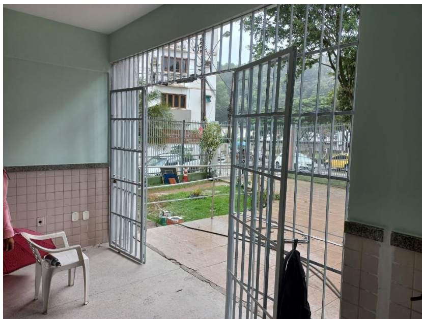
Foto 01: Pintura de grades
