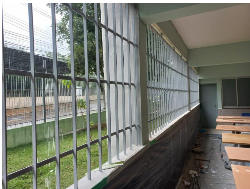
Foto 03: Pintura de grades
