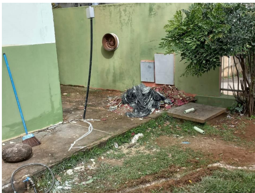
Foto 12: entulho das remoções de reboco
