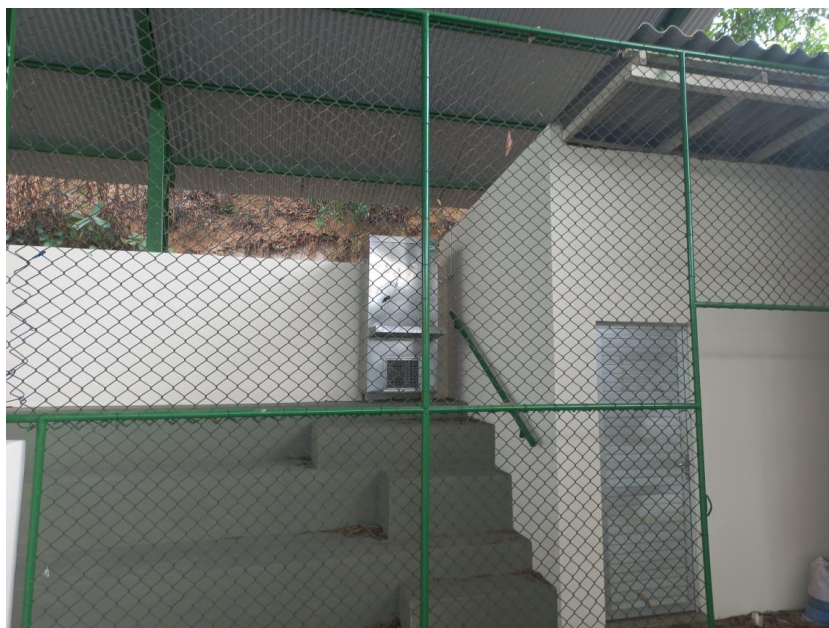
Foto 02: Pintura de parede
