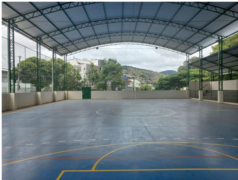
Foto 01: Pintura de piso
