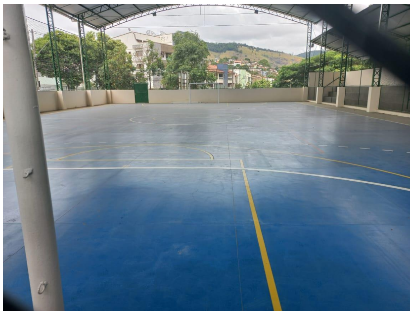
Foto 04: Pintura de piso
