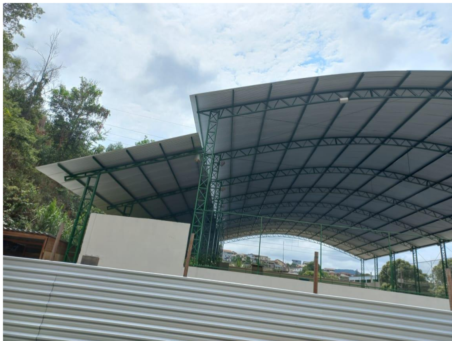
Foto 01: Cobertura nova em telha metálica
