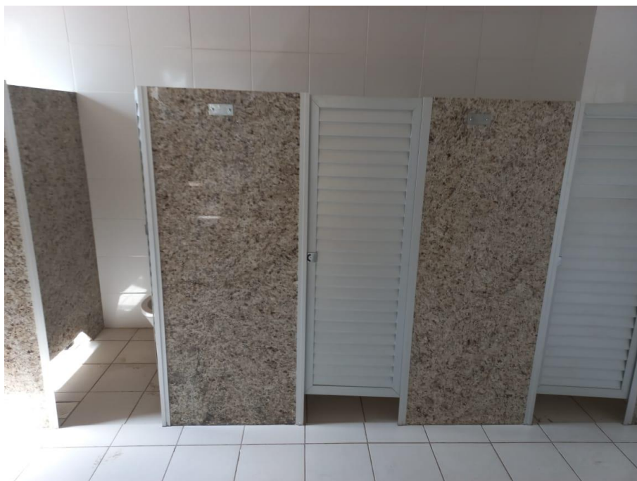
Foto 05: Porta de alumínio para divisória banheiro
