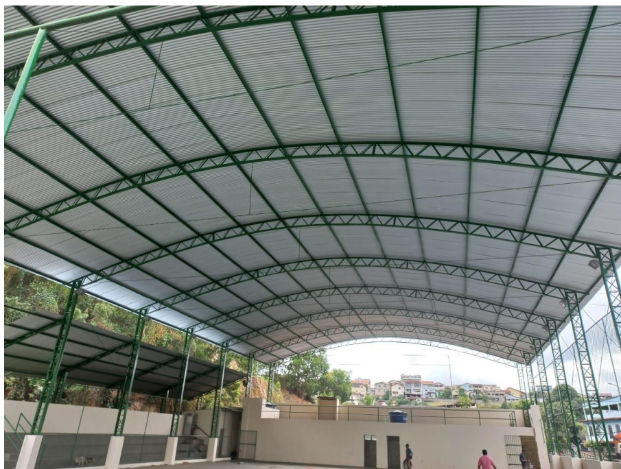
Foto 03: Cobertura nova em telha metálica
