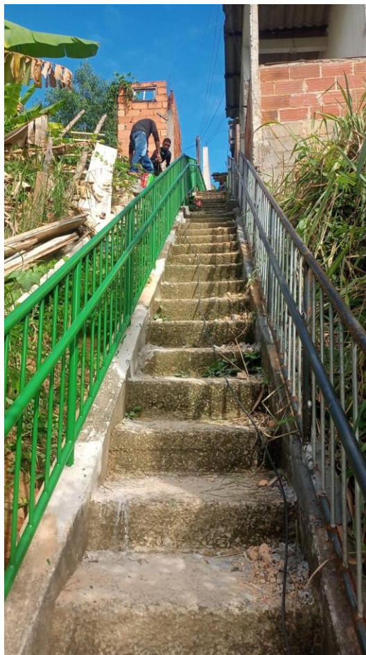
Foto 05: guarda-corpo escada finalizando pintura
