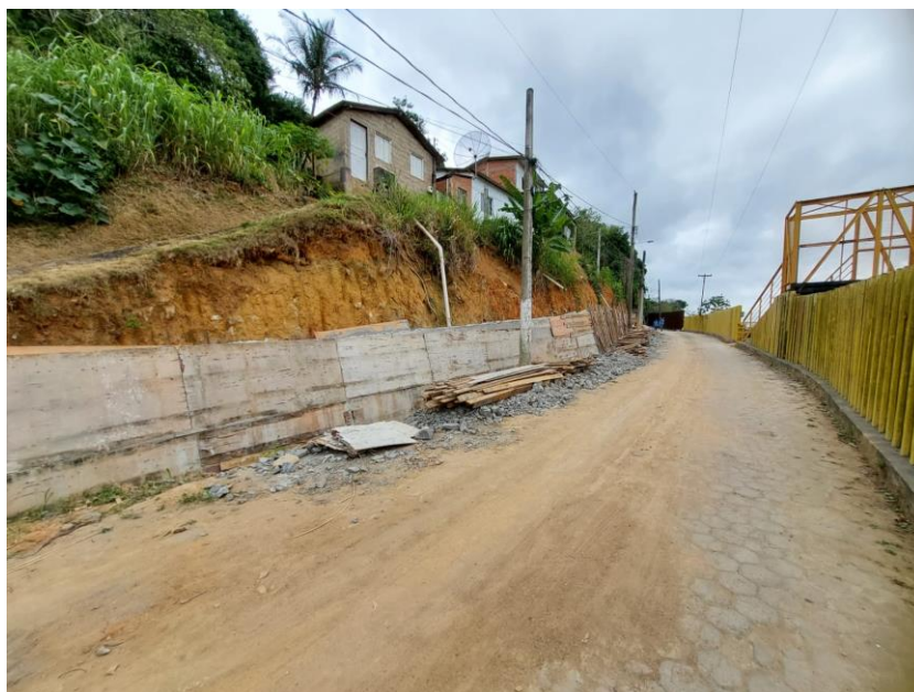
Foto 05: forma do muro
