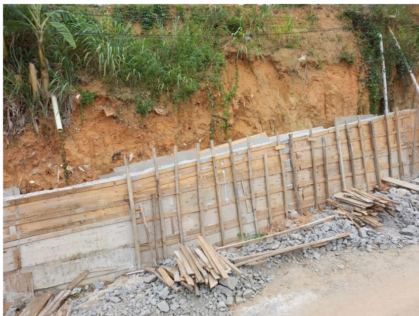
Foto 06: forma do muro
