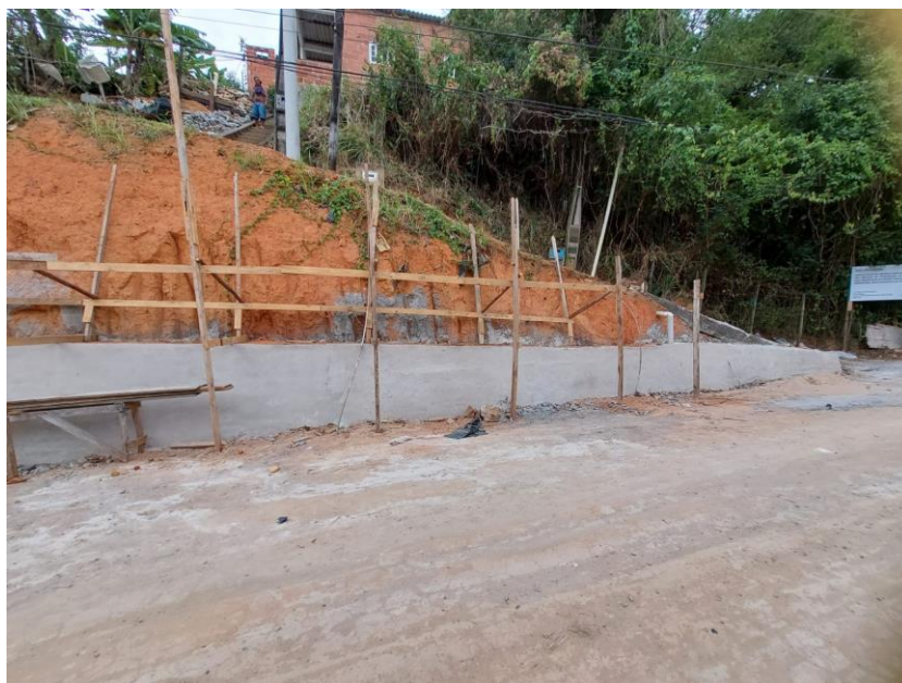
Foto 07: desforma do muro
