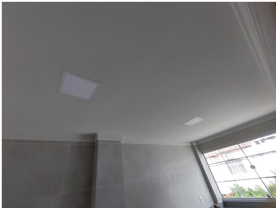
Foto 12: forro de gesso
