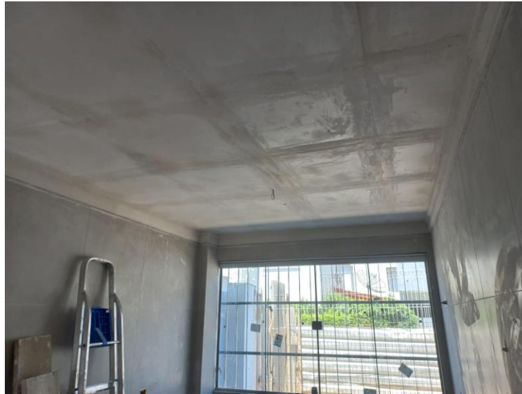
Foto 05: Forro de gesso
