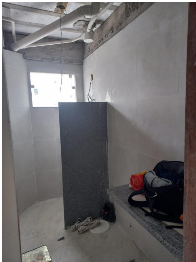
Foto 05: banheiro 1º pavimento
