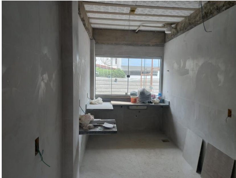
Foto 04: revestimento de parede
