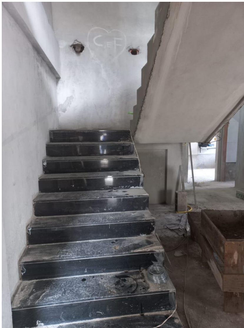
Foto 09: revestimento da escada
