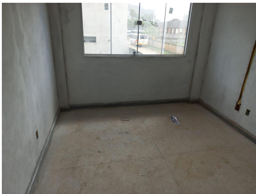
Foto 02: aplicação de selador
