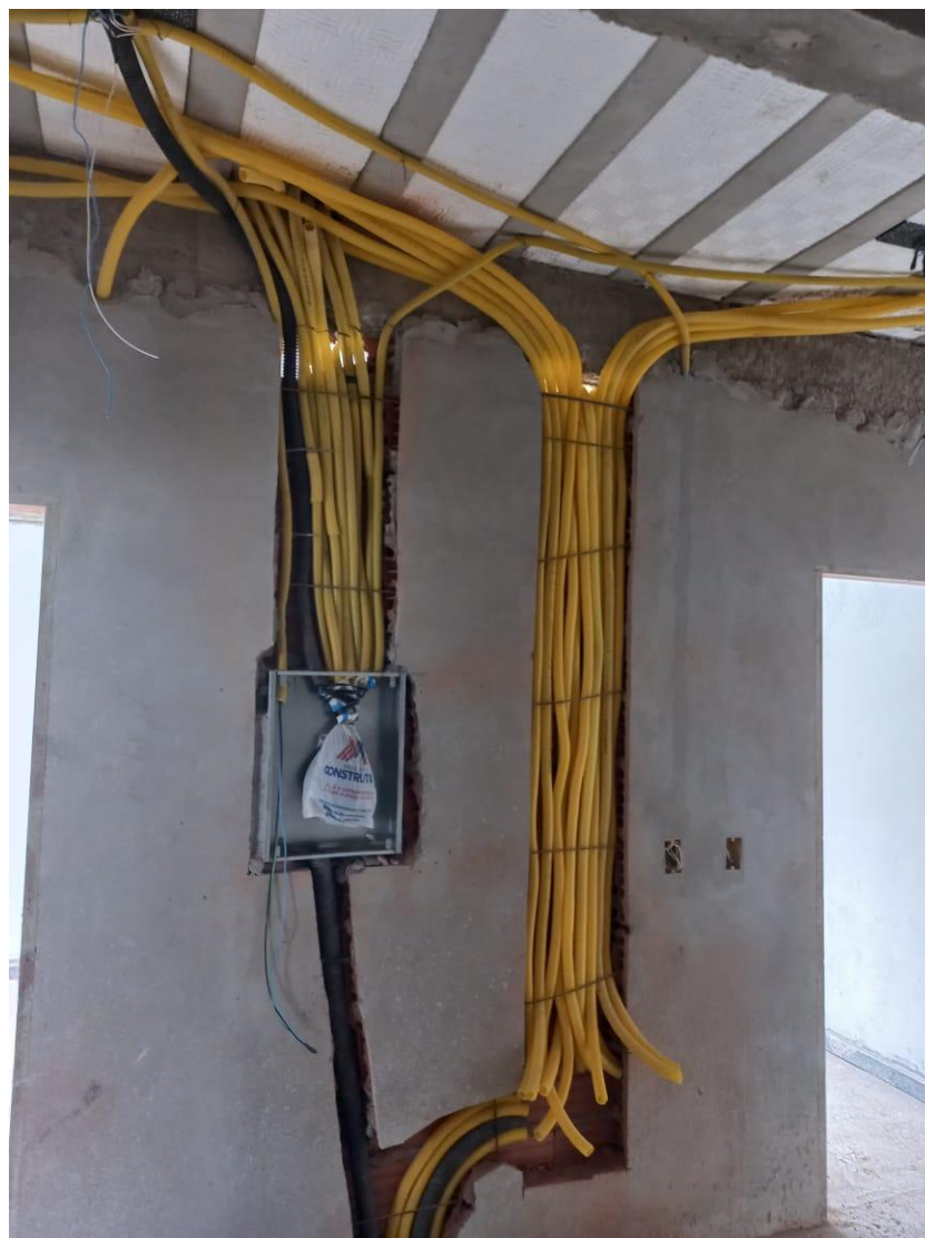
Foto 06: fiação elétrica
