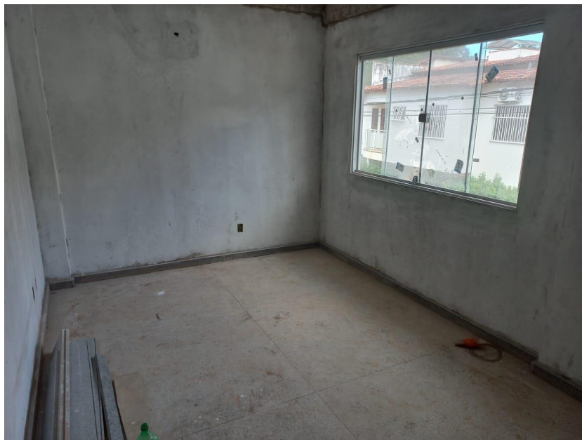
Foto 07: janela, piso granilite e selador
