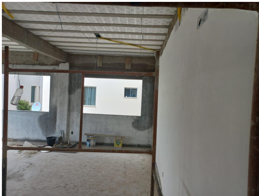
Foto 01: aplicação de selador
