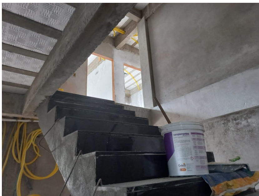
Foto 08: revestimento da escada
