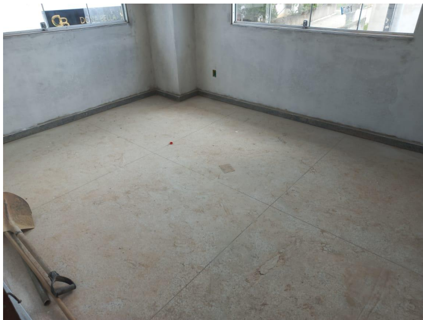
Foto 04: aplicação de selador
