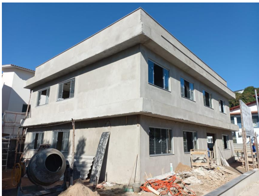
Foto 01: fachada da obra
