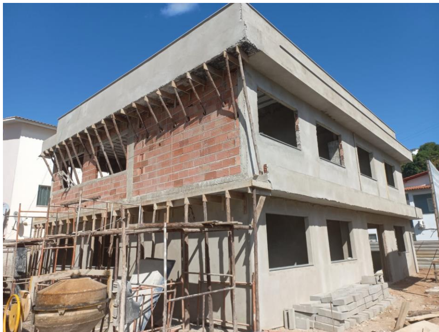
Foto 08: reboco externo
