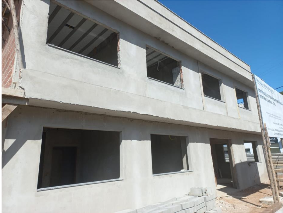
Foto 01: fachada interna da obra
