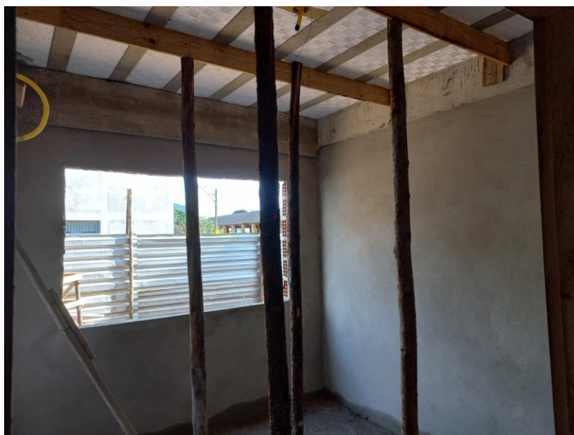
Foto 07: reboco interno
