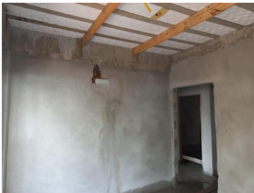
Foto 03: reboco interno
