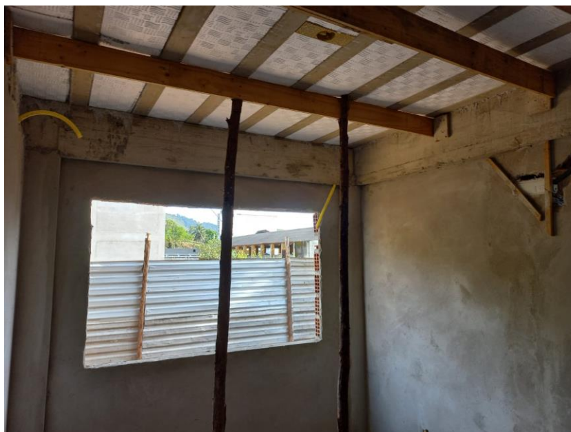
Foto 06: reboco interno
