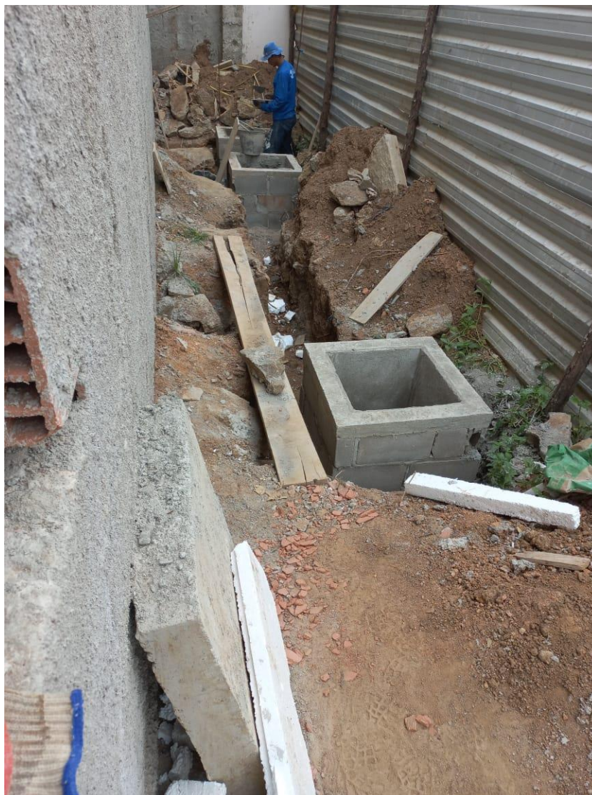
Foto 05: caixas de inspeção
