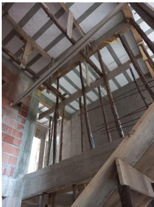
Foto 03: escoramento de laje e pontos elétricos
