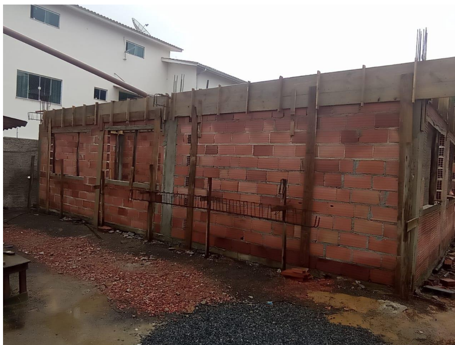
Foto 04: formas das vigas
