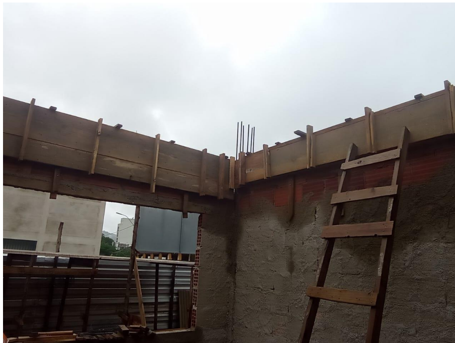
Foto 05: Vigas concretadas
