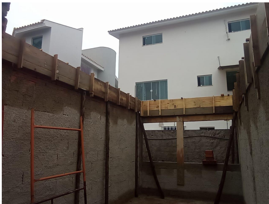
Foto 01: Vergas e vigas
