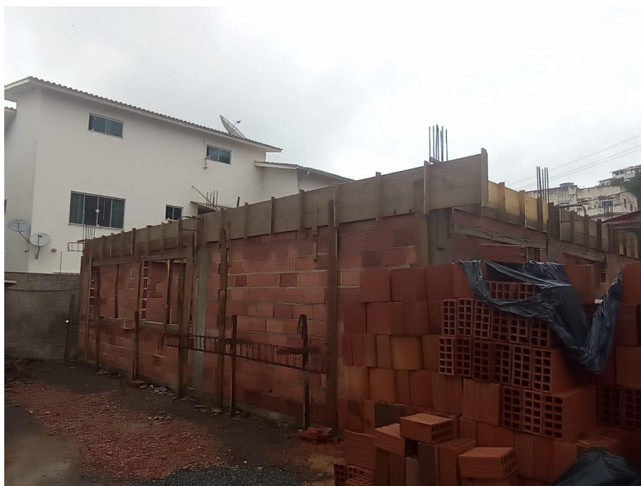
Foto 02: formas das vigas
