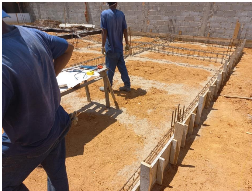
Foto 01: dobra e colocação em forma de ferragem
