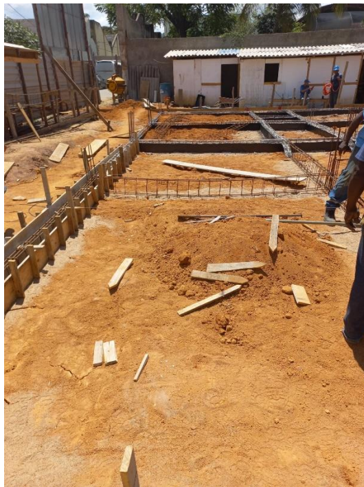
Foto 03: montagem de forma
