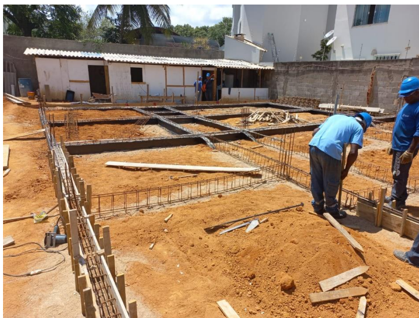
Foto 04: montagem de forma
