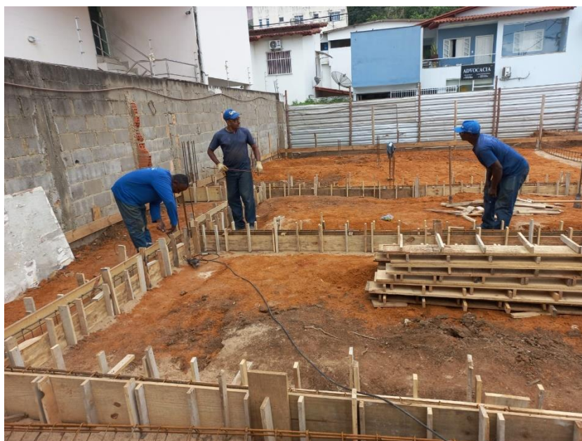
Foto 02: dobra e colocação em forma de ferragem
