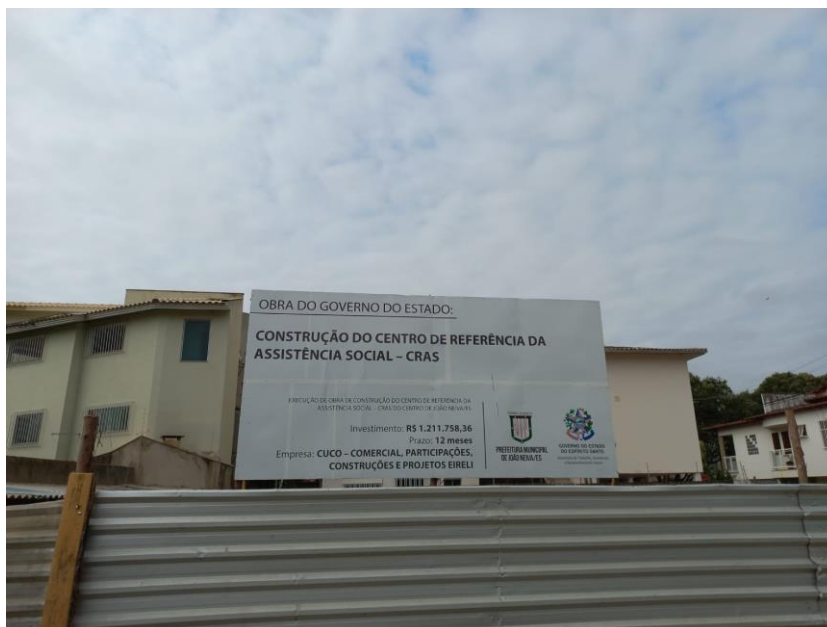
Foto 01: Placa de obra
